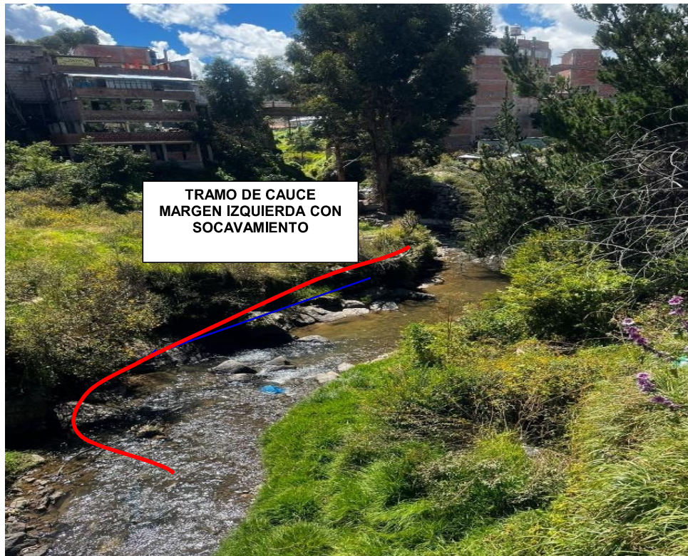
FIGURA N° 02: RIO CONDE EXPUESTO ANTE UNA CRECIDA CON SOCAVAMIENTO EN LA ZONA PLANA.
