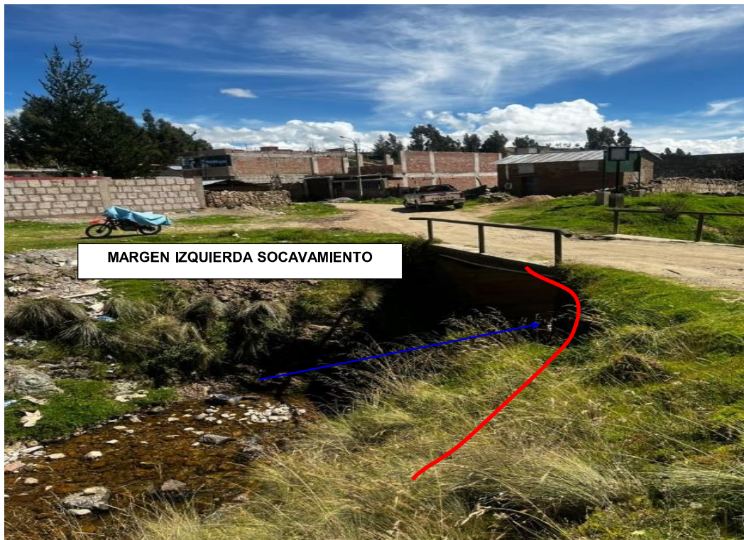
FIGURA N° 01: TRAMO CRÍTICO EN RIO CONDE, CON SOCAVAMIENTO EN LA MARGEN IZQUIERDA
